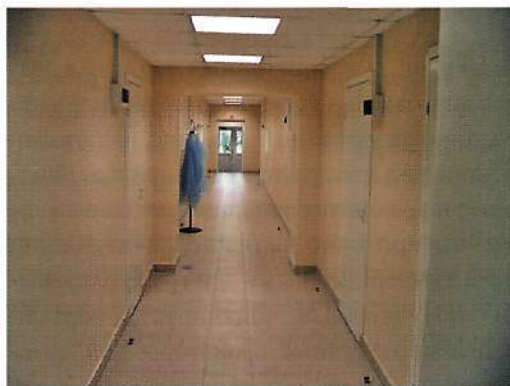
Рис. 7. Общий вид «чистого коридора» лабораторного корпуса
