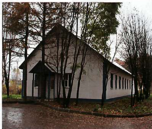
Рис. 6. Общий вид лабораторного корпуса
